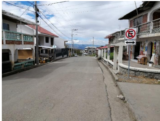
FOTOGRAFÍA NRO. 40 VIA DE CACHIPAMBA DE ASFALTO EN REGULAR
