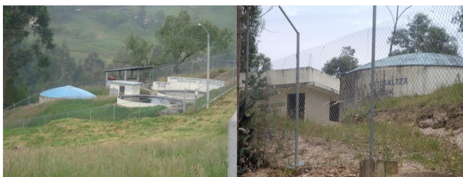
FOTOGRAFÍA NRO. 30 PLANTA DE TRATAMIENTO DE AGUA POTABLE REGIONAL: BUIL GUAPÁN: FILTROS DE ARENA-CASETA DE CLORACIÓN FUENTE: EQUIPO CONSULTOR
