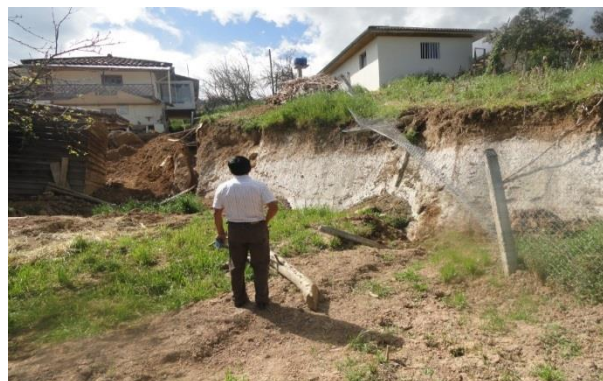
FOTOGRAFÍA NRO. 18 CANAL DE AGUA EN LA PARTE ALTA DEL DESLIZAMIENTO QUE PUEDE SER LA CAUSA DE ESTE MOVIMIENTO FUENTE: EQUIPO CONSULTOR ELABORADO POR: EQUIPO CONSULTOR
