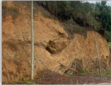
FOTOGRAFÍA NRO. 10 IMPRODUCTIVO ELABORADO POR: EQUIPO CONSULTOR
