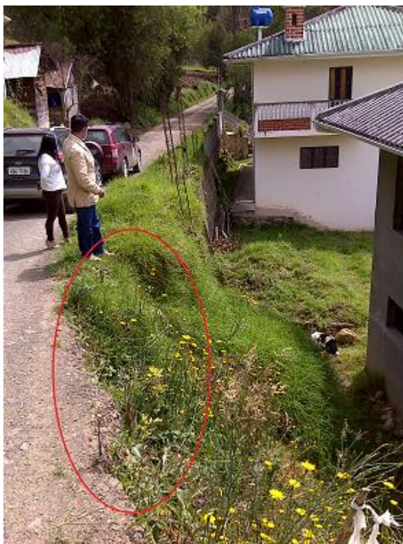
FOTOGRAFÍA NRO. 27 PERDIDA DE LA MESA DE LA VIA FUENTE: EQUIPO CONSULTOR ELABORADO POR: EQUIPO CONSULTOR
