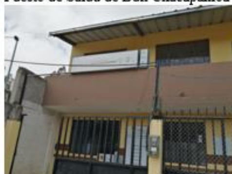
Puesto de Salud de Buil Chacapamba
