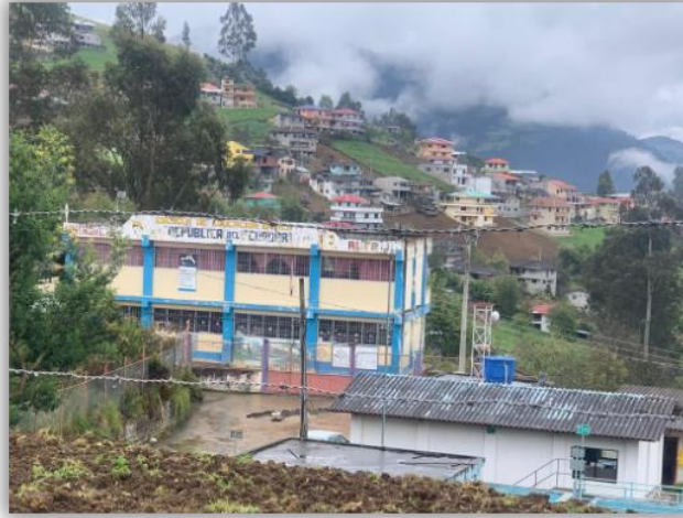
FOTOGRAFÍA NRO. 9 HABITACIONAL ELABORADO POR: EQUIPO CONSULTOR
