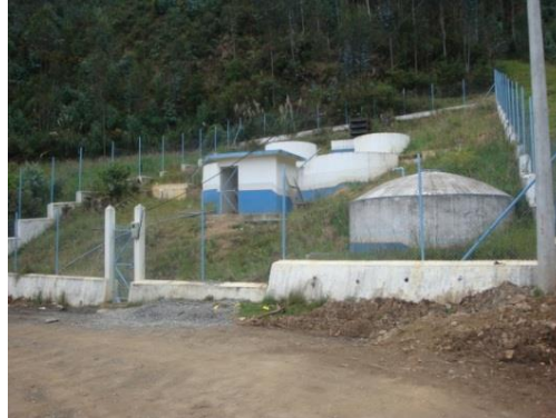
FOTOGRAFÍA NRO. 31 PLANTA DE TRATAMIENTO DE AGUA POTABLE QUINUA –ALLIYACU FUENTE: EQUIPO CONSULTOR
