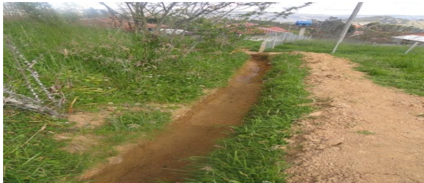
FOTOGRAFÍA NRO. 22 CUNETAS REALIZADAS POR LOS MORADORES FUENTE: EQUIPO CONSULTOR ELABORADO POR: EQUIPO CONSULTOR
